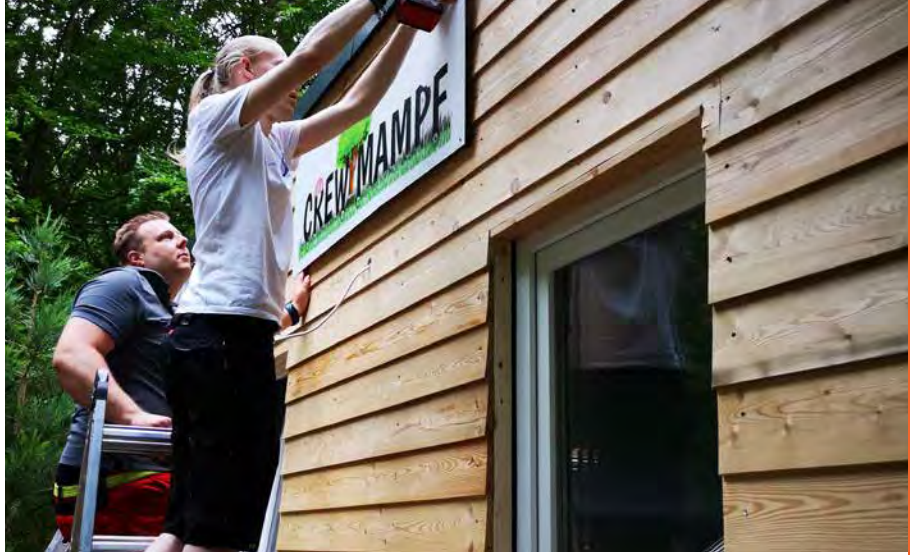
Das Bauwagen-Bistro errichten die „CREW“ in Eigenleistung: Hier wird tatkräftig angepackt.
